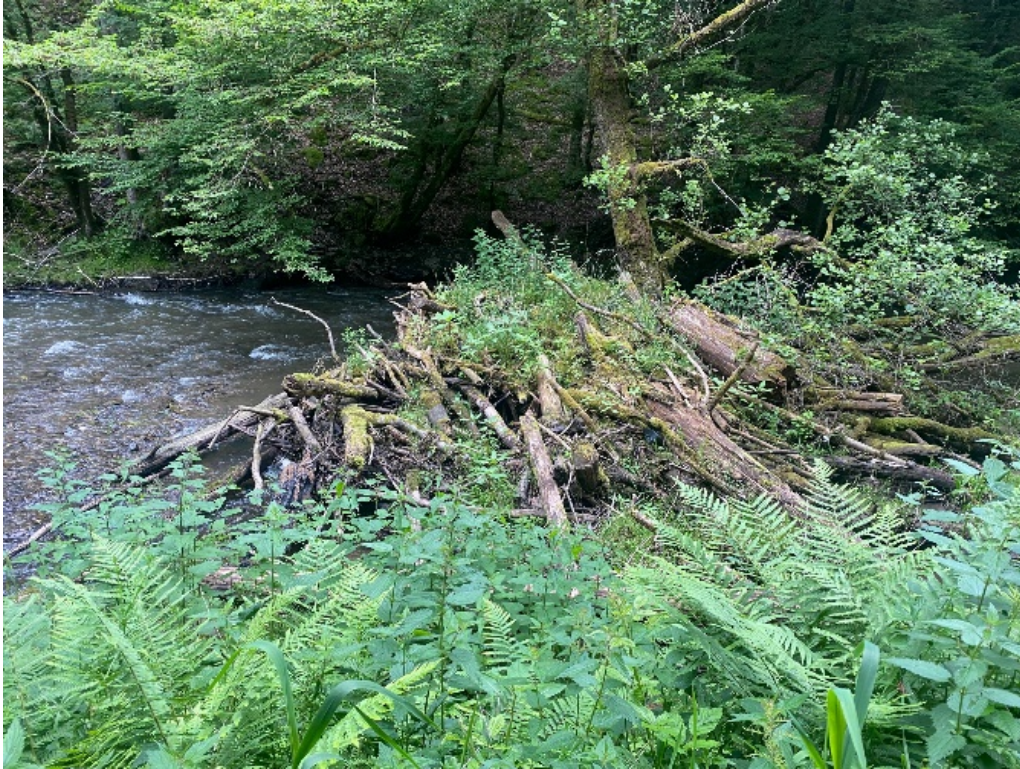
Abbildung 3 Holzansammlung an wasserführendem Bach im Zuflussbereich der Mosel. Bei Starkregenereignissen und sprunghaft ansteigendem Wasserstand auf mehrere Meter droht das Totholz am Ende im aufnehmenden Fluss u. a. vor Brücken Staulagen mit möglichen verheerenden Folgen
